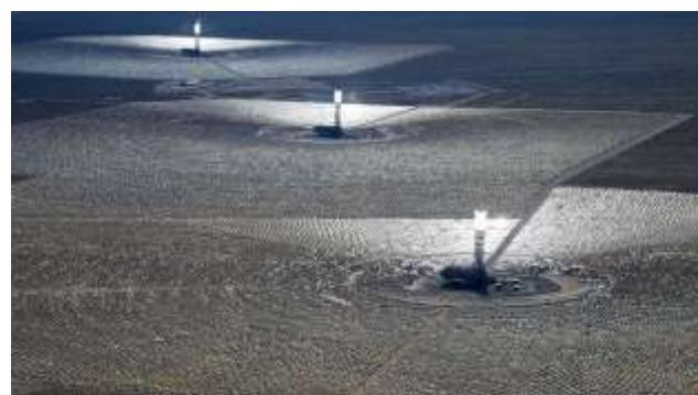
Autobahn I-15, welche Las Vegas mit Los Angeles verbindet. Es ist ein konzentrierendes Solarkraftwerk. Voller 172'000 Heliostaten, die eine Fläche von 16 Quadratkilometern bedecken, lenken das Sonnenlicht auf die Spitzen von drei Türmen, wo es Dampf mit hohen Druck erzeugt, der Turbinen und Generatoren antreibt. Es kostete 2,2 Milliarden US\$ und ging 2014 in Betrieb.
